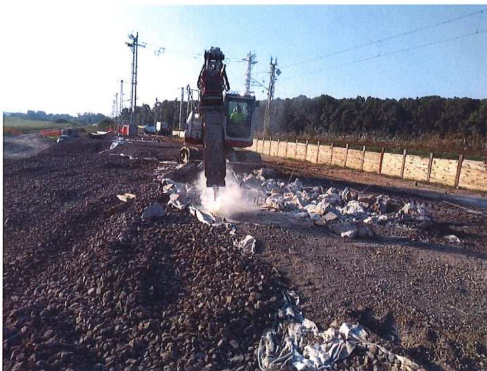
Búranie základov pod pomocnými zariadeniami pre výsun mosta – SO 12-33-04
