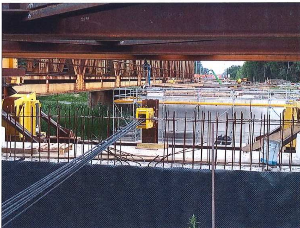
Príprava výsuvného zariadenia na opore OP1 – SO 12-33-04
