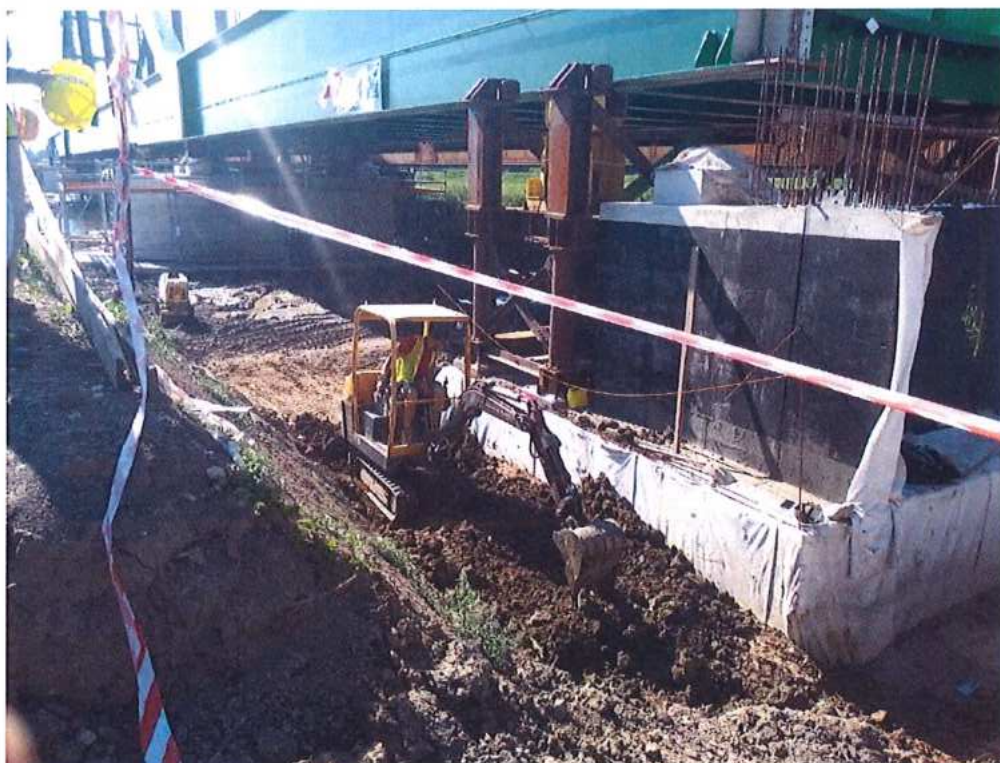
Zriadenie hrádze pri opore OP2 na strane CZ – SO 12-33-04
