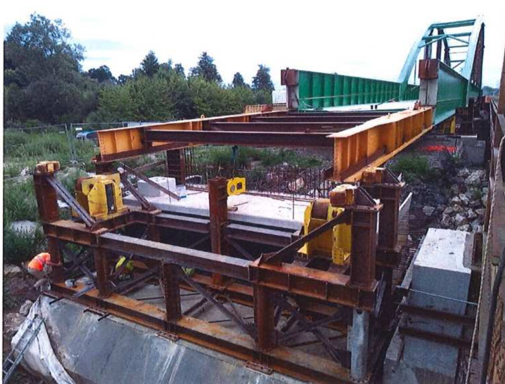
Príprava výsuvného zariadenia mosta cez rieku Morava na opore OP1 – SO 12-33-04
