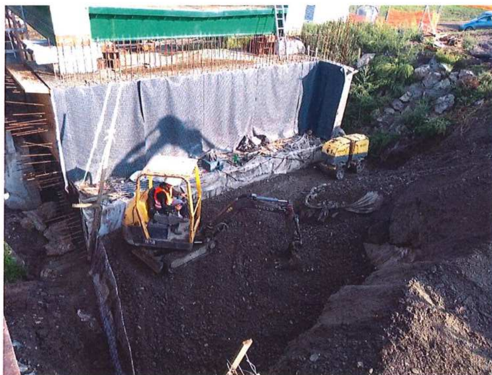
Realizácia zásypov pri OP1 – SO 12-33-04
