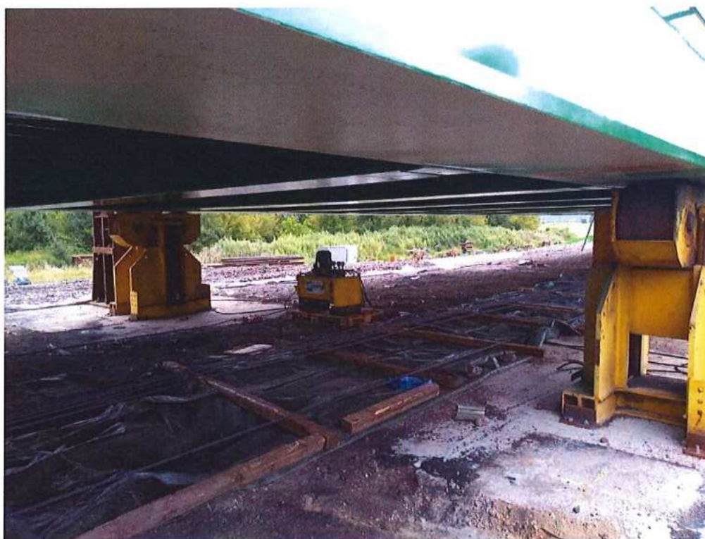
Hydraulické čerpadlo na zdvih valčekových zariadení – SO 12-33-04
