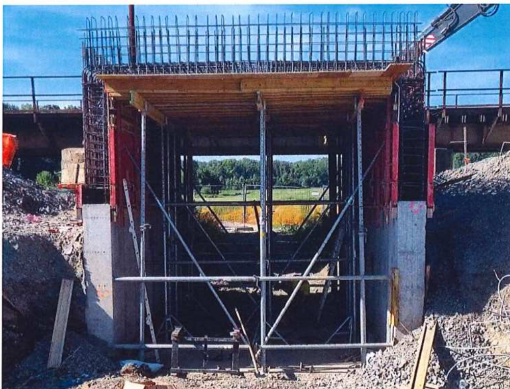
Armovanie a debnenie stien a stropu – SO 12-33-03
